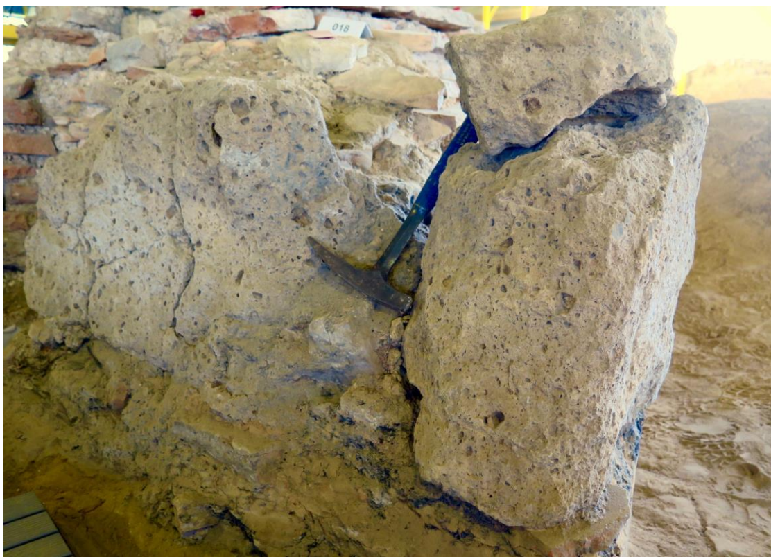
Fig.26. Grote blokken vulkanische tufsteen (Römer Tuff) in het oostelijk praefurnium van het badhuis.
