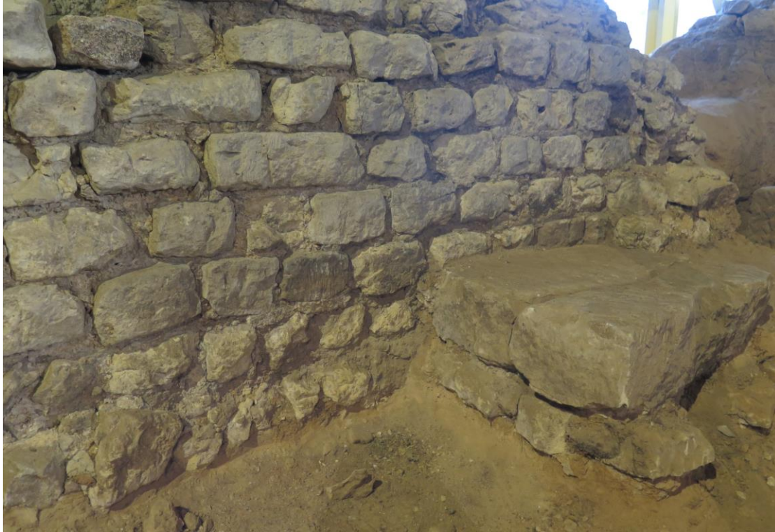
Fig.17. Parement van een binnenmuur gemaakt uit blokjes Kunradersteen, met op de voorgrond enkele grote blokken Kunradersteen. Ten W van het zuidelijk praefurnium .
