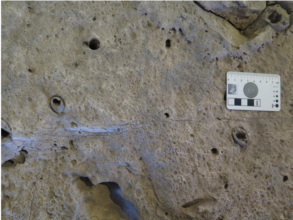
Fig.1. Detail van verkiezelde graafgangen (bioturbaties) in een grote plaat Kunradersteen. NW-gedeelte van het badhuis.
