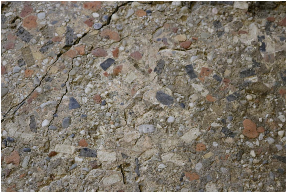
Fig.16. Cementvloer met rode baksteenfragmenten, gele tegelfragmenten, witte kiezelsteentjes (kwarts), donkergrijze platte keitjes (vuursteen), zwarte en lichtgele mozaïeksteentjes (respectievelijk Kunradersteen en Theux marmer). Apodyterium en frigidarium van het badhuis.
