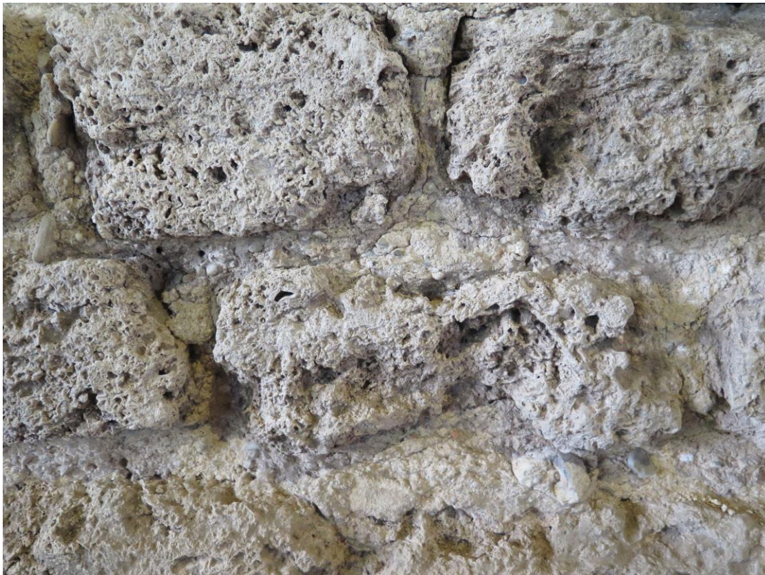
Fig.7. Detail van fig.6: blokjes beige kalktuf met karakteristieke sponsachtige textuur.
