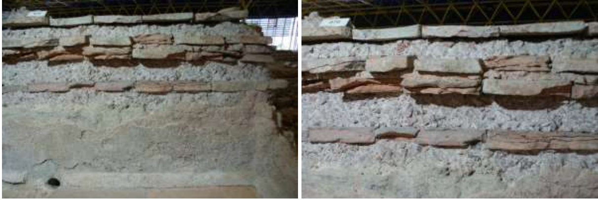
Figuur 58 Westelijke muur met gebroken bouwpuin en speklagen van keramisch bouwmetaal in oostelijke frigidarium bad – ruimte 5.
