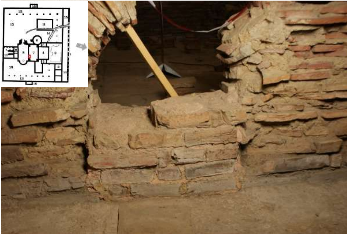
Figuur 115 Dichtzetting van een van de boogjes tussen tepidarium en caldarium, gezien vanuit het tepidarium – ruimte 7.
