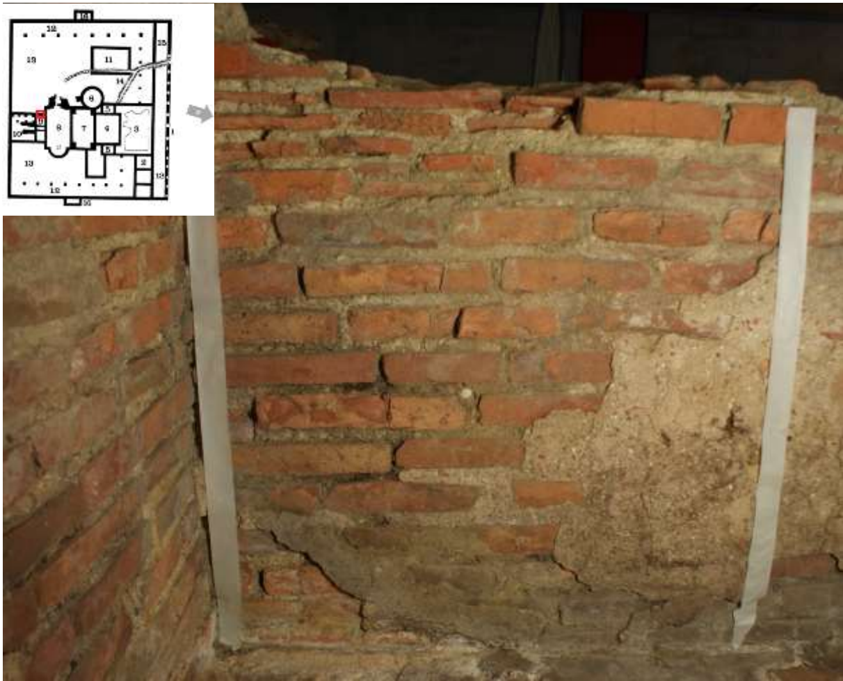
Figuur 90 Westmuur van keramisch bouwmetaal in alveus - ruimte 9.
