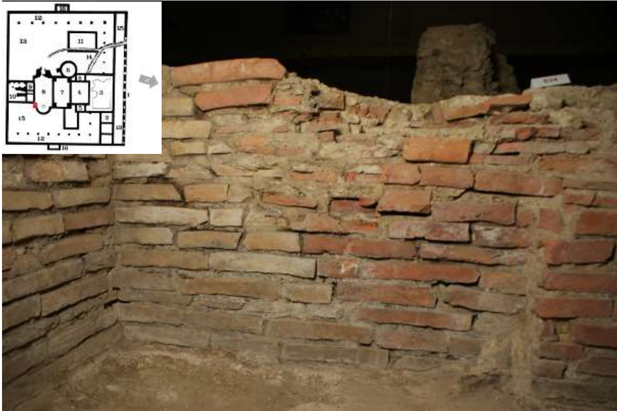
Figuur 83 Muur van keramisch bouw materiaal in caldarium, zuidelijke muur – ruimte 8.
