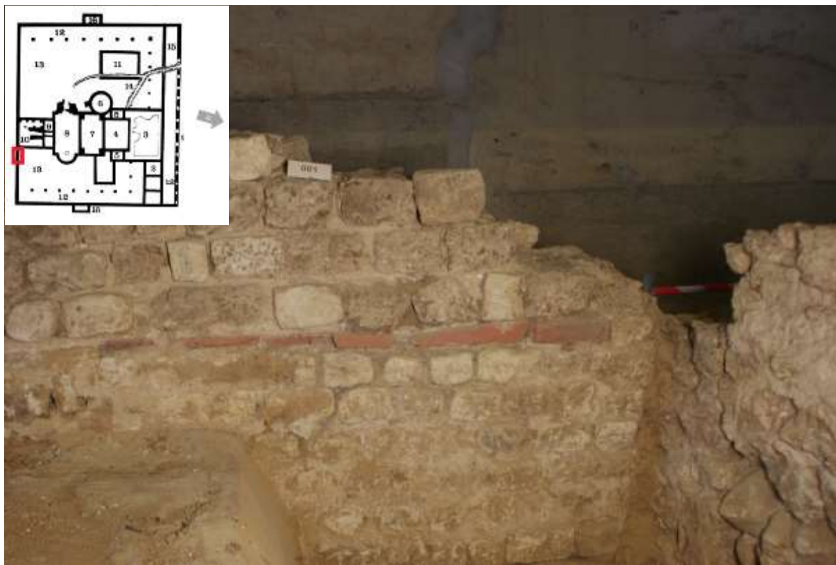
Figuur 107 Speklaag van keramisch bouwmetaal in zuidmuur – ruimte 1.
