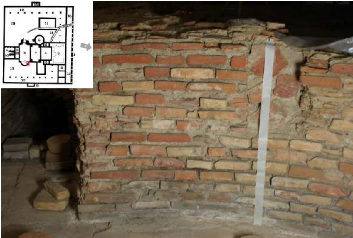
Figuur 118 Muur van keramisch bouw materiaal in caldarium, oostelijke absidale muur – ruimte 8.
