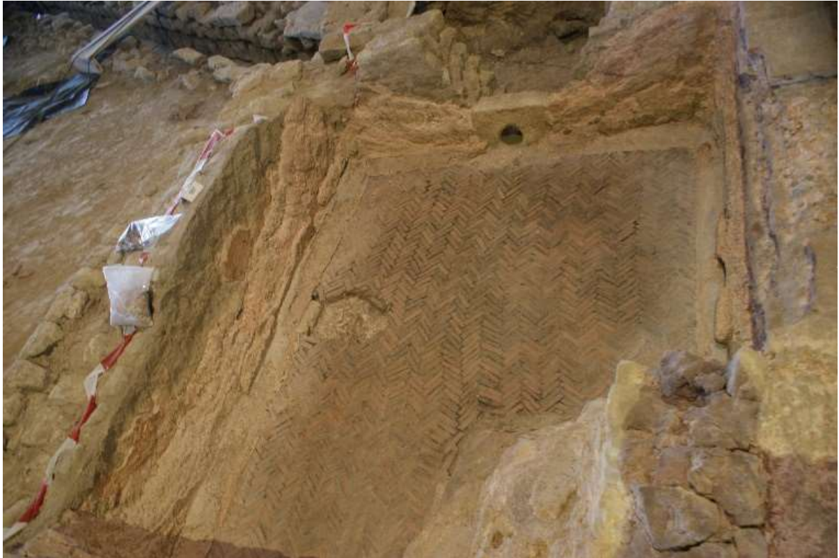
Figuur 60 Vloer van keramisch bouwmetaal (opus spicatum) in westelijke frigidarium bad- ruimte 5.
