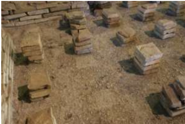
Figuur 75 Pilae van keramisch bouw materiaal in tepidarium, voor de schoonmaak – ruimte 7, duidelijk zichtbaar de afdrucken waar vroeger stapeltjes hebben gestaan.
