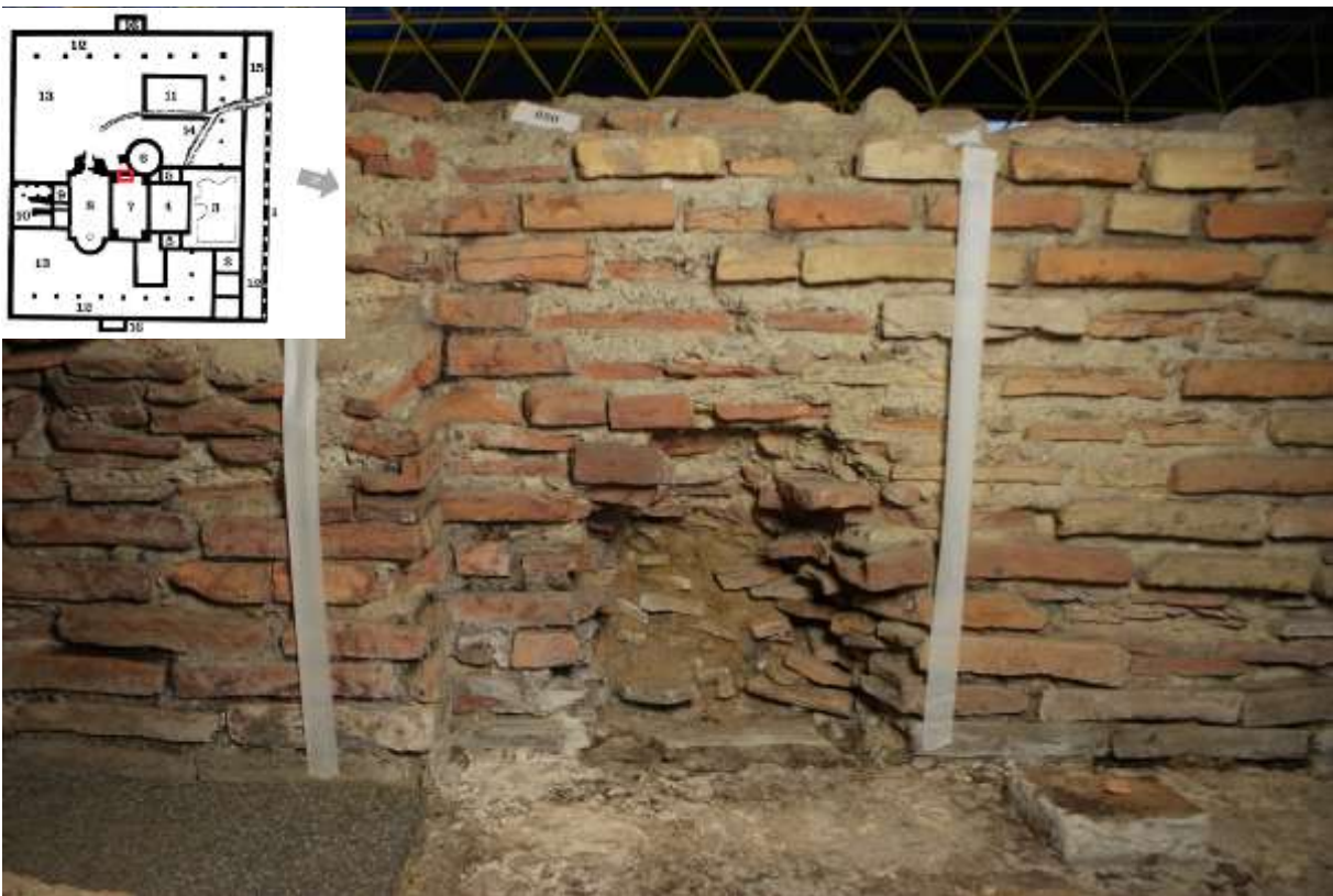
Figuur 74 Muur van keramisch bouw materiaal in tepidarium, westmuur – ruimte 7.
