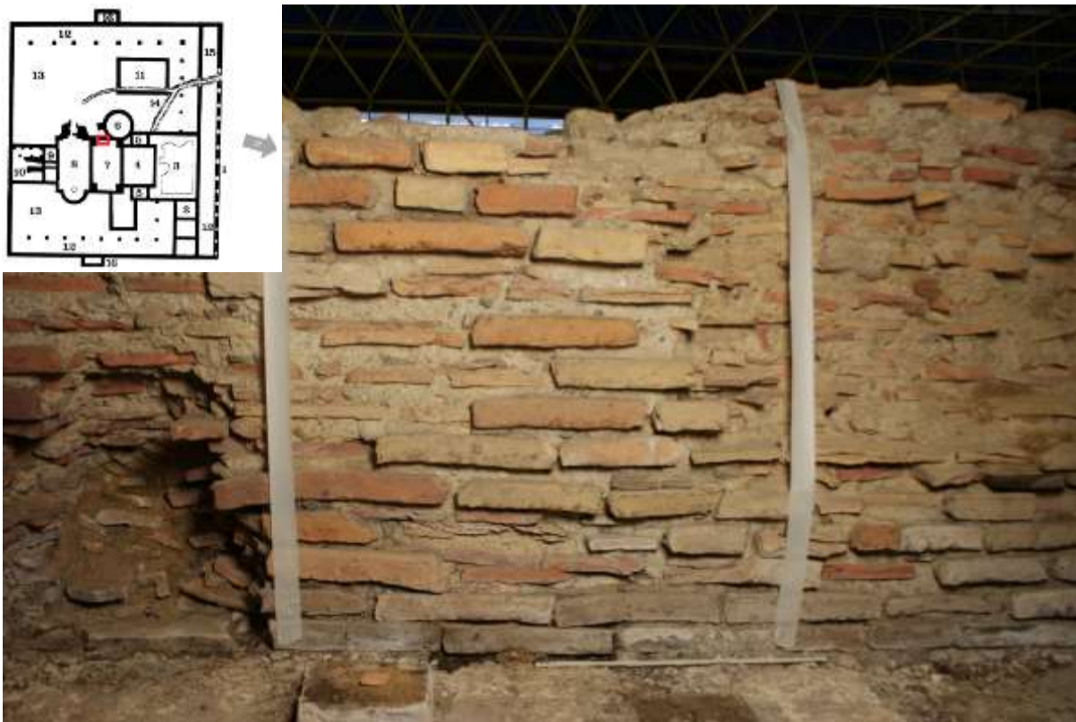
Figuur 113 Muur van keramisch bouw materiaal in tepidarium, westmuur – ruimte 7.
