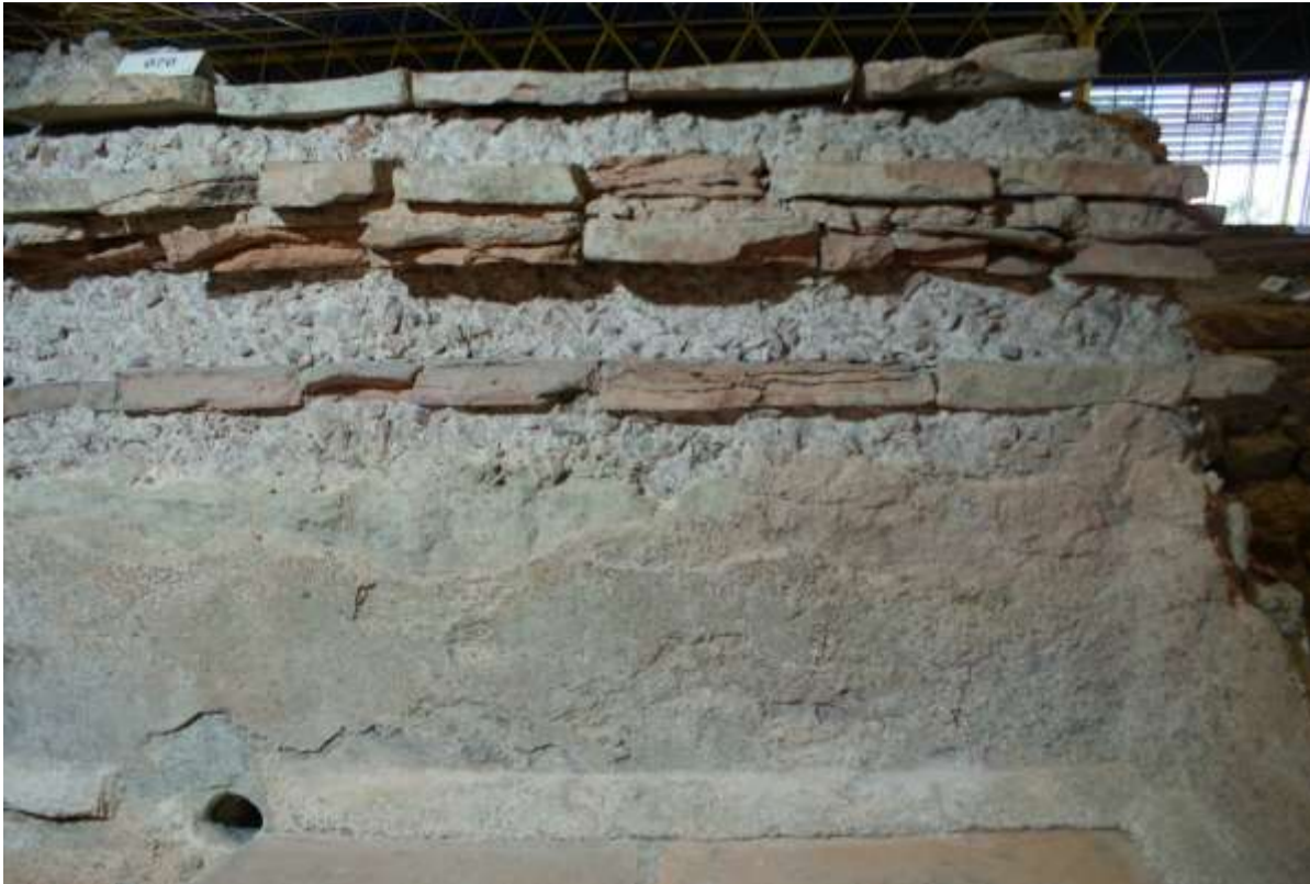
Figuur 108 Keramisch bouwmetaal in westelijke muur, oostelijk frigidarium bad - ruimte 5.
