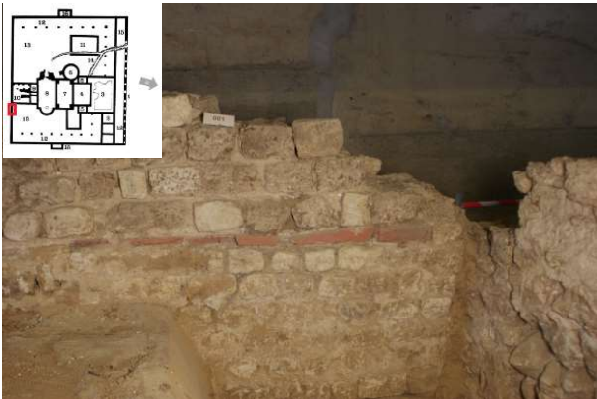
Figuur 48 Speklaag van keramisch bouw materiaal in zuidmuur - ruimte 1.
