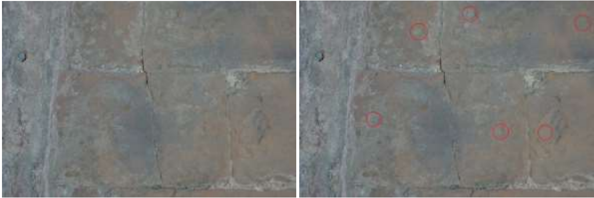
Figuur 53 Vloer van keramisch bouwmetaal in frigidarium, lydia met kleine ronde indrukken – ruimte 4.
