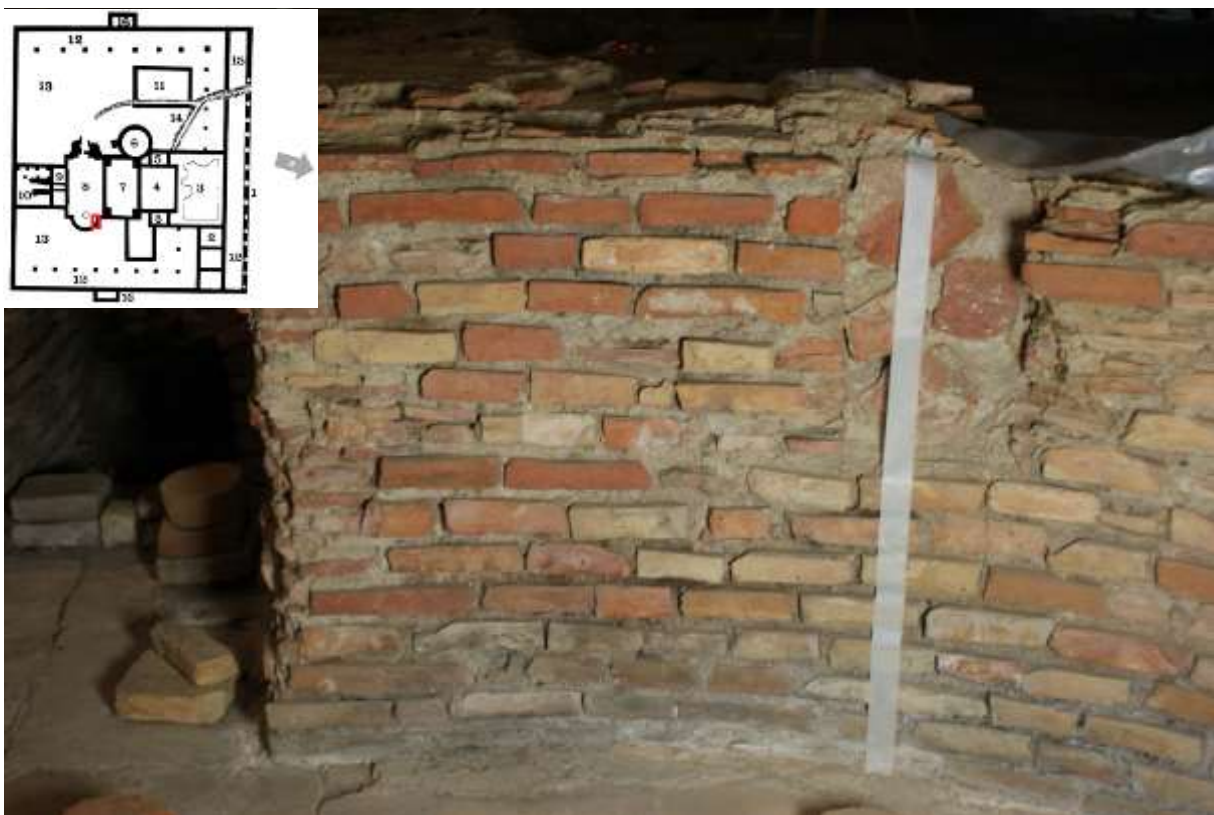
Figuur 82 Muur van keramisch bouw materiaal in caldarium, oostelijke absidale muur – ruimte 8.
