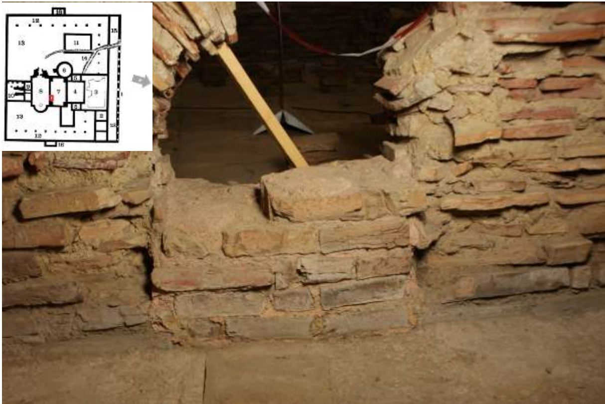
Figuur 79 Dichtzetting van een van de boogjes tussen tepidarium en caldarium, gezien vanuit het tepidarium – ruimte 7.
