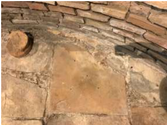
Figuur 87 Vloer van keramisch bouwmetaal in caldarium – ruimte 8.
