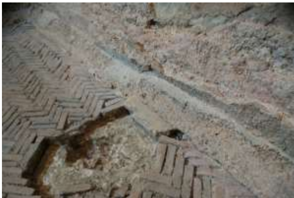
Figuur 61 Vloer van keramisch bouwmetaal (opus spicatum) in westelijke frigidarium bad, met vierkante bessalis in baksel B – ruimte 5.
