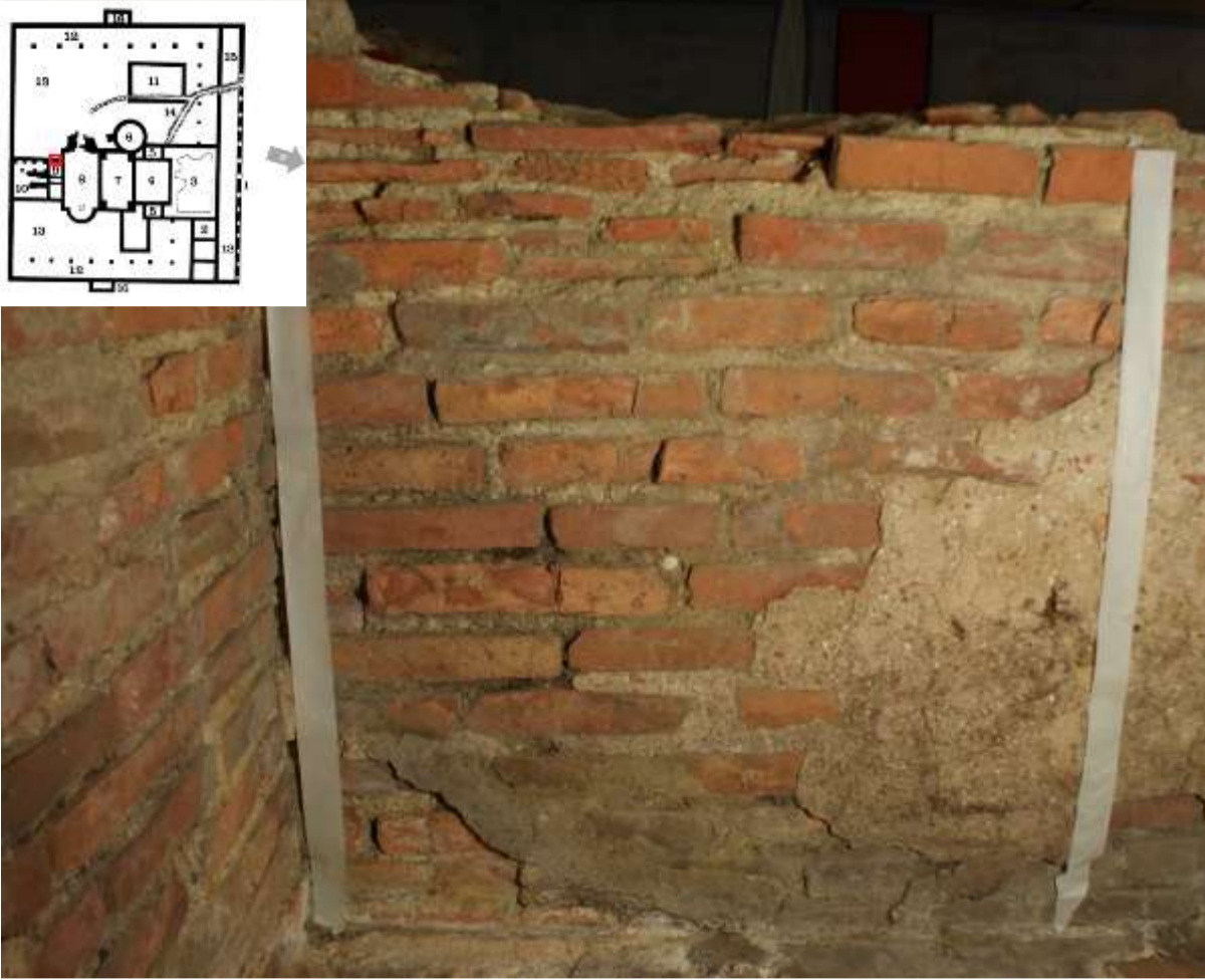
Figuur 121 Muur van keramisch bouw materiaal in alveus, westmuur – ruimte 9.
