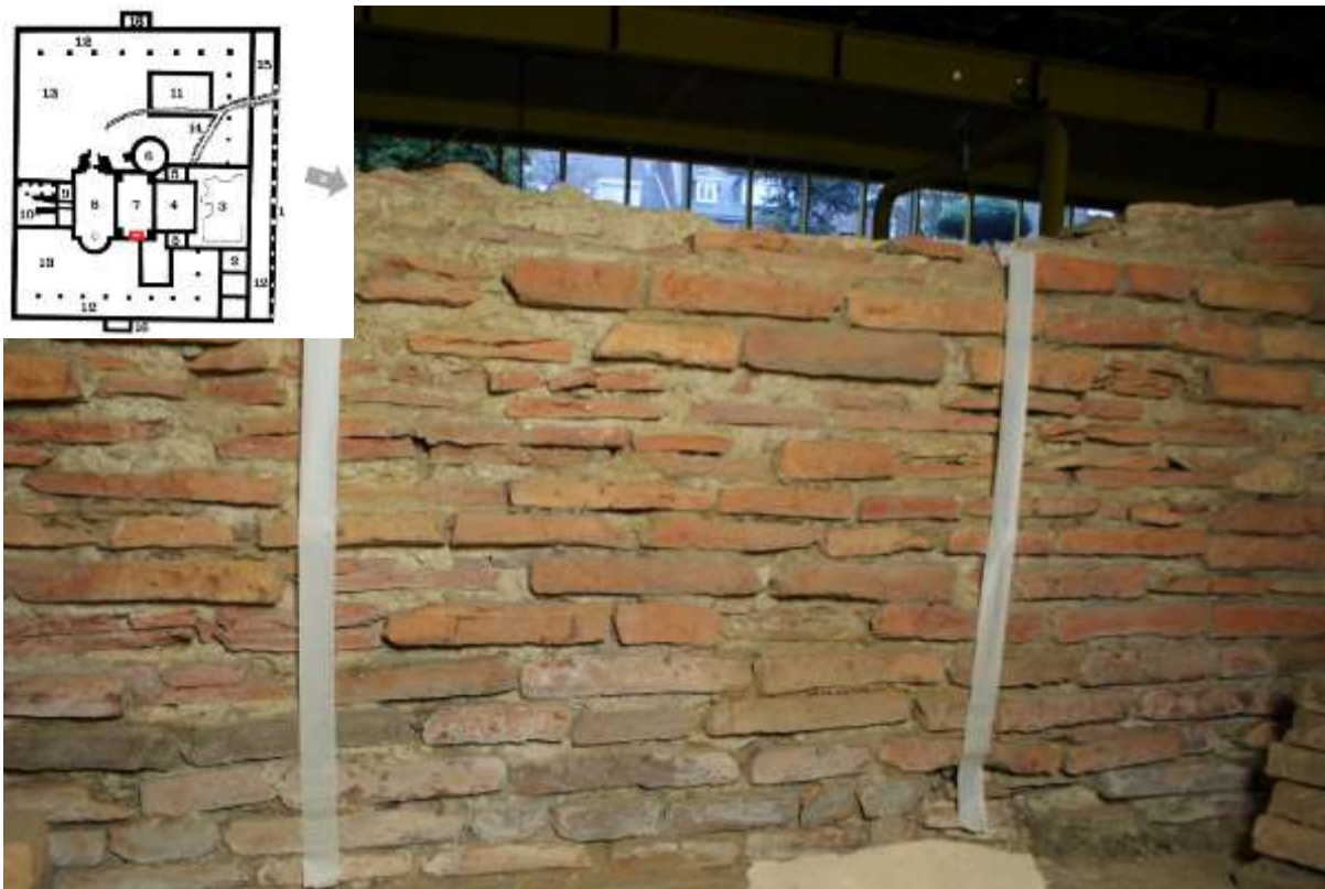
Figuur 111 Muur van keramisch bouw materiaal in tepidarium, oostmuur - ruimte 7.
