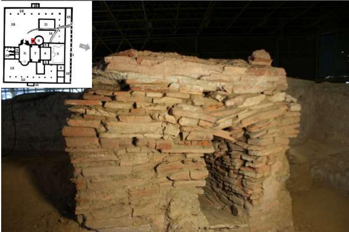
Figuur 66 Rommelige secundaire stookmond van keramisch bouwmetaal aan de buitenzijde van het sudatorium – ruimte 6.
