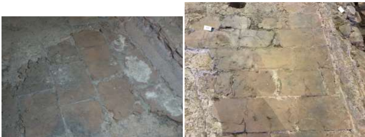
Figuur 52 Vloer van keramisch bouwmetaal in frigidarium, lydia – ruimte 4.
