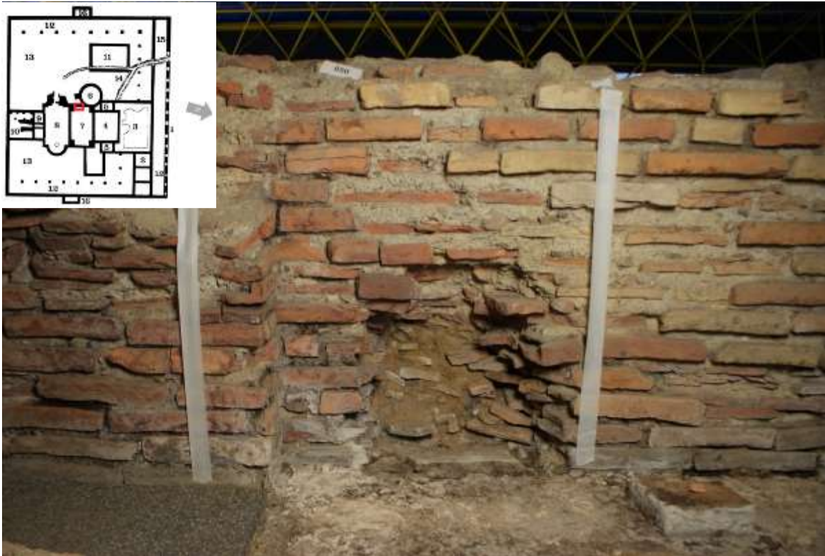
Figuur 114 Muur van keramisch bouw materiaal in tepidarium, westmuur – ruimte 7.
