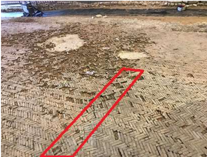
Figuur 50 Vloer van keramisch bouw materiaal ( opus spicatum ) in entreehal – ruimte 3, met op de voorgrond zichtbaar een breuklijn waar de richting van de visgraat verandert.
