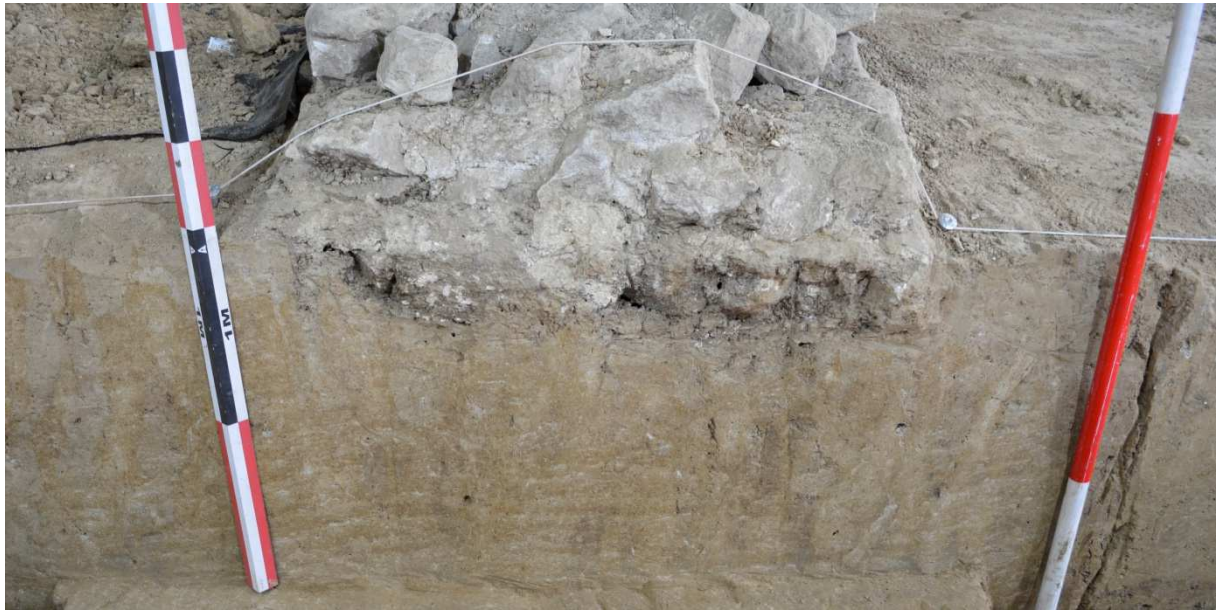
Figuur 17. Het zuilfundament in het zuidprofiel van put 1.
