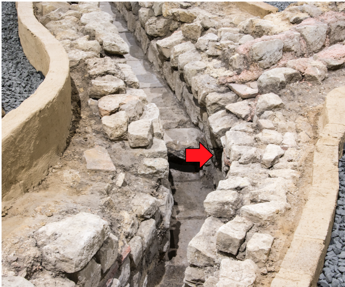
Afb 2.14 Buitenbad, (#15) bodemafvoer komt in centrale afvoer (#26) (de donkere vlek rechts midden) (foto: Thermenmuseum, A. Steen)
