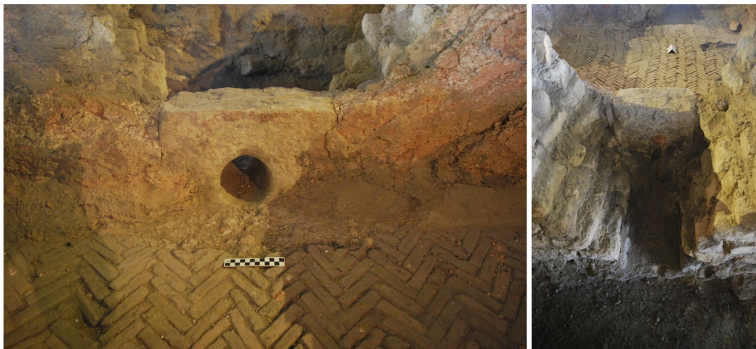
Fig. 2.10 Westbad (#5), afvoer vanuit bad, en afvoer vanuit centrale afvoer van het badgebouw (foto's: auteur).
