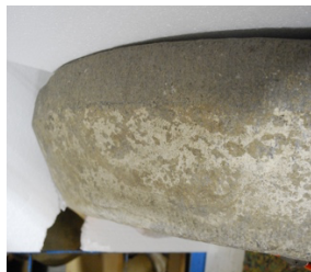
Fig. 2.32 Stucresten aan onderzijde labrum (foto: auteur).
