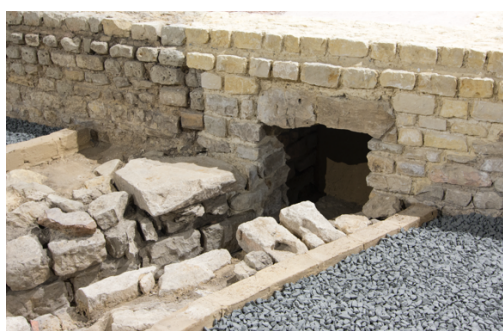
Fig. 4.4 Centrale afvoer (#26) breekt door reeds bestaande buitenmuur van het badgebouw (bovenste rechte stenen zijn modern) (foto: Thermenmuseum, A. Steen).
