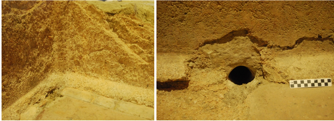
Fig. 2.5 Oostbad (#4), horizontale en verticale naden voor afdichten van hoeken (foto: auteur).
