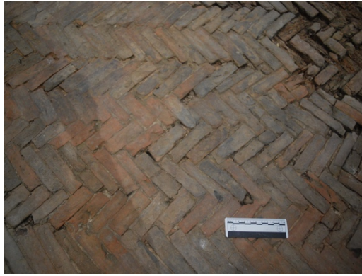
Fig. 2.40 Vloer van omkleedruimte (#2) gelegd in opus spicatum (foto: auteur).
