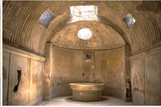
Fig. 2.31 Pompeji, Forum thermen, gemetselde voet onder groot labrum (foto: internet).
