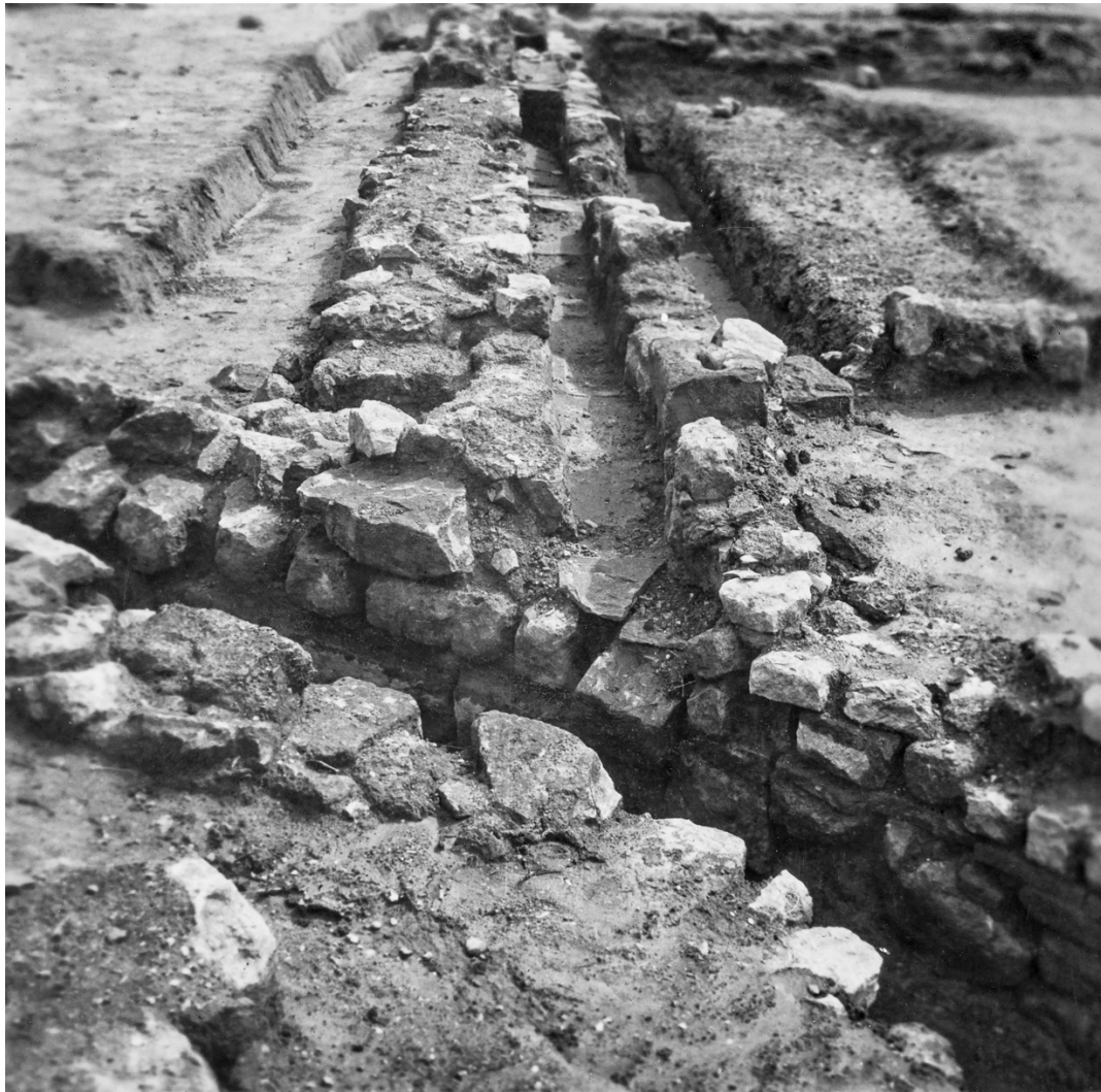
Fig. 4.11 Centrale afvoer (#26), punt waar zwembadwater erin geloosd wordt, blikrichting zuid (en de afvoer dieper komt te liggen, situatie 1941 (foto: Thermenmuseum Heerlen).
