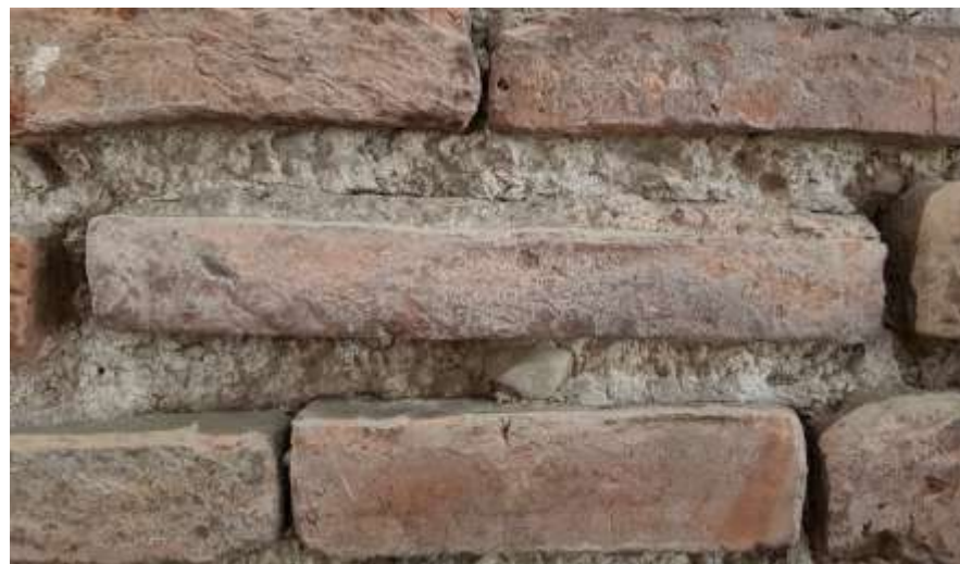
Afb. 2.32 In de tussenmuur zijn hergebruikte keramische bouwstenen toegepast (foto: PANSa BV).
