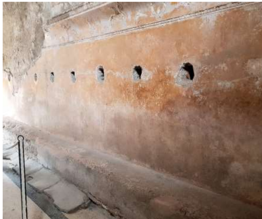
Afb. 2.11 Stenen zit- en voetenbank in het apodyterium van de Forumthermen van Pompeii. De secundaire voetenbank is op de mozaïekvloer geplaatst (foto: PANSA BV).
