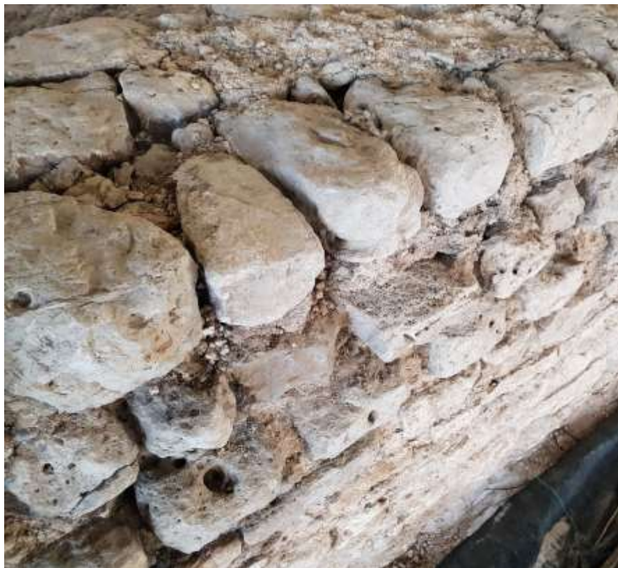
Afb. 2.9 Apodyterium , westelijke funderingsmuur; terugspringend muurwerk bij de overgang van fundering naar opgaand muurwerk (foto: PANSA BV). De aansluiting van de oostelijke en westelijke funderingsmuur aan de piscinae van het frigidarium wordt gemaakt met gereconstrueerd muur-
