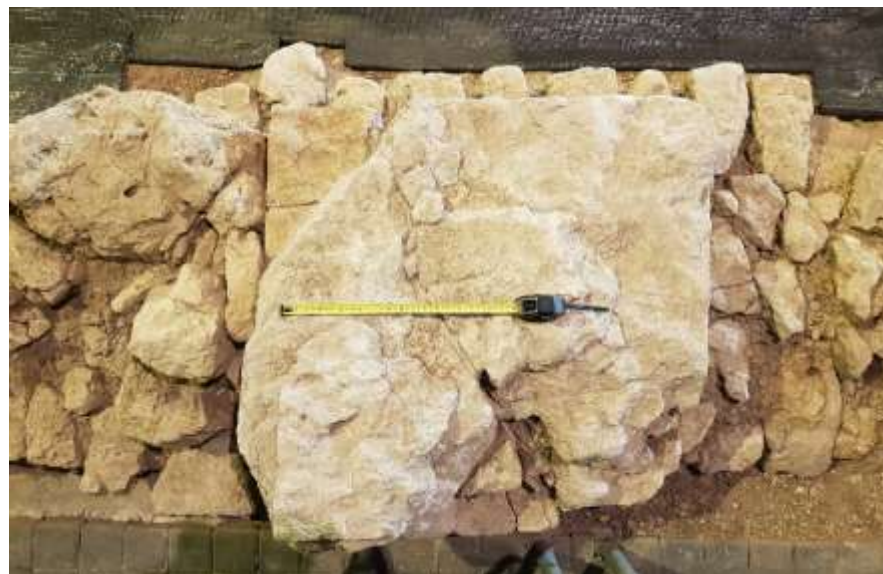
Afb. 2.7 Porticus , noordelijke funderingsmuur met zesde basisblok van Norroy kalksteen (foto: PANSa BV).
