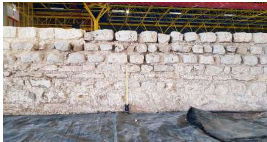
Afb. 2.8 Apodyterium , westelijke funderingsmuur met onderscheid in het muurwerk tussen de onderste en bovenste helft (foto: PANSA BV).
