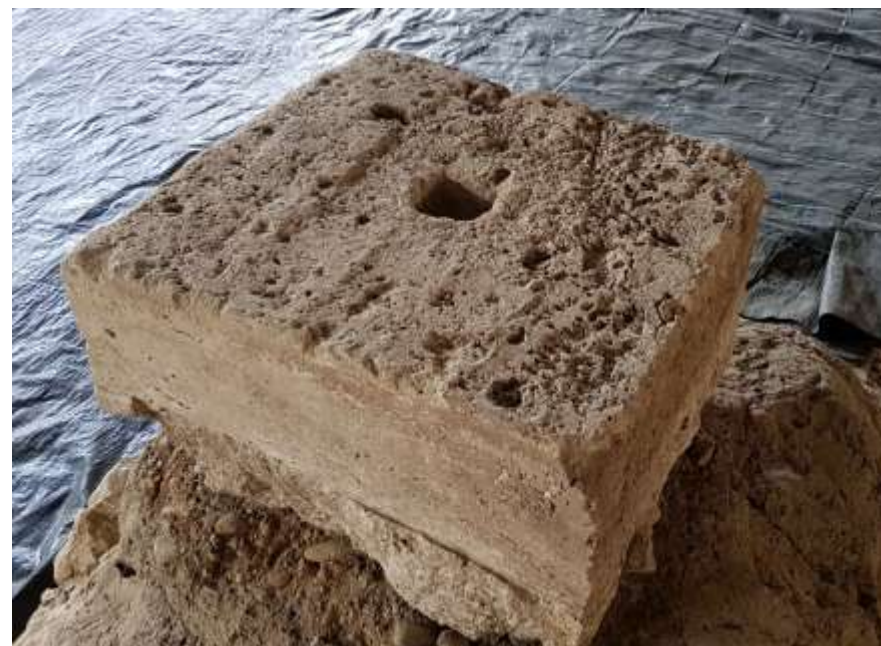
Afb. 2.71 Vijfde basisblok van L-vormige porticus toont cesuur tussen het onbewerkte onderste deel en het zorgvuldig bewerkte bovenste deel (foto: PANSA BV).
