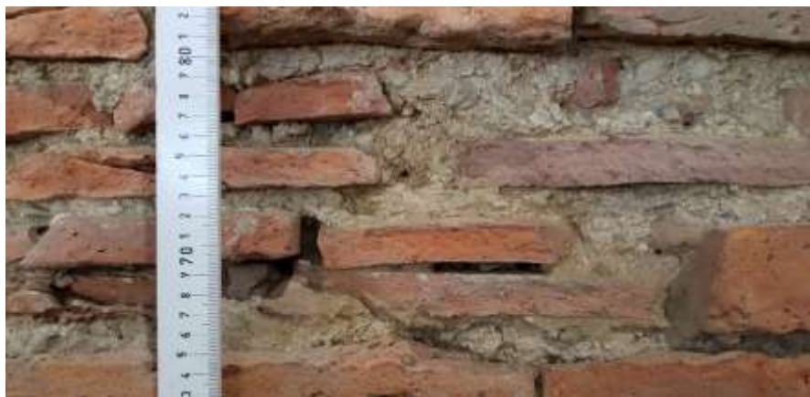
Afb. 2.24 Het opus latericium van het tepidarium laat zien dat de verschillende partijen mortel niet zeer nauwkeurig volgens één receptuur zijn aangemaakt (foto: PANSA BV).
