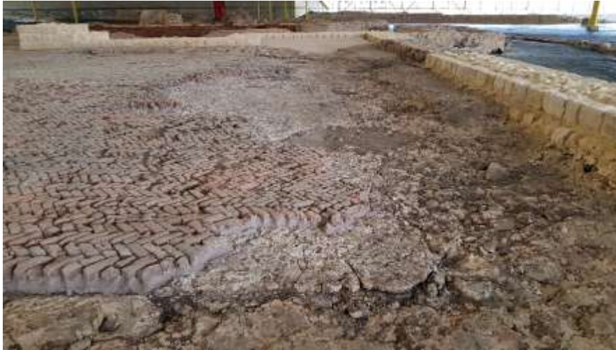
Afb. 2.12 Het meest westelijke deel van de vloer van het apodyterium vertoont een aanzienlijke verzakking (foto: PANSA BV).
