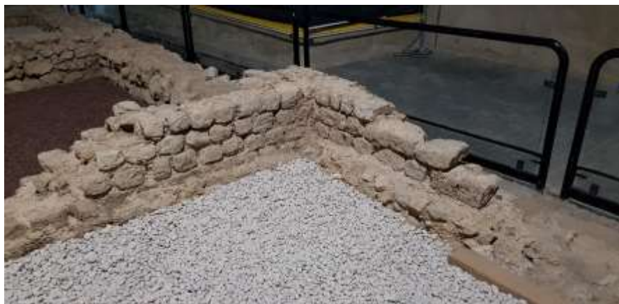
Afb. 2.67 De oostmuur (rechts) en de noordmuur (links) van de oostelijke palaestra vormen een bouwkundige eenheid (foto: PANSa BV).
