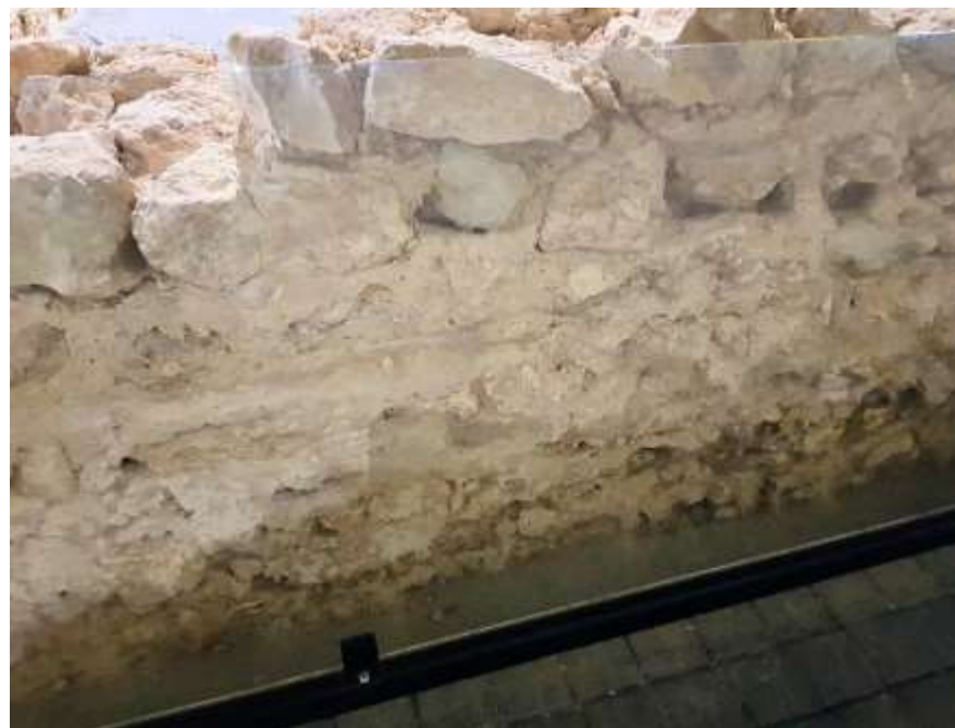
Afb. 2.64 Oostelijke palaestra , zuidzijde zuidmuur (foto: PANSa BV).
