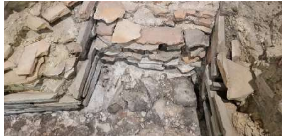
Afb. 2.28 Luchtdoorvoer naar sudatorium gezien vanuit tepidarium (foto: PANSA BV).
