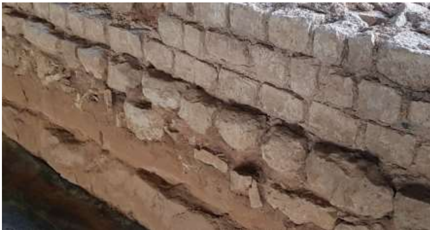
Afb. 3.4 Zuidmuur westelijke palaestra ; inspringing markeert overgang tussen fundering en opgaand werk in opus vittatum simplex (foto: PANSA BV). Een andere indicatie dient zich aan bij de westmuur van het apodyterium . De sprong in het muurwerk ligt hier op 113,85 m NAP (afb. 3.5). De mor-
