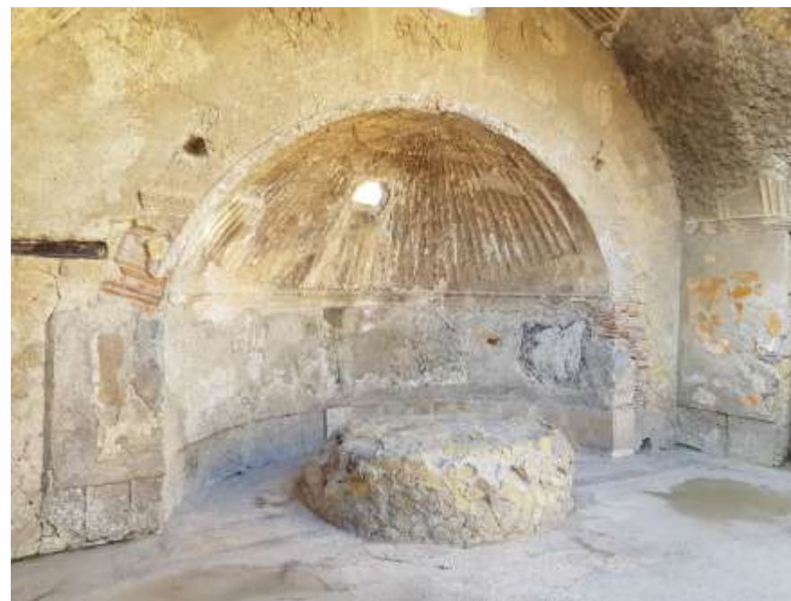
Afb. 2.36 Forumthermen in Herculaneum met gemetselde ronde basis voor het labrum (foto: PANSA BV).
