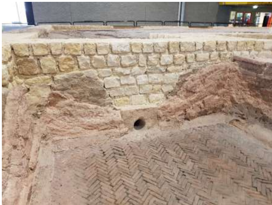
Afb. 2.15 Blok met afvoer in de noordmuur van de westelijke piscina (foto: PANSA BV).
