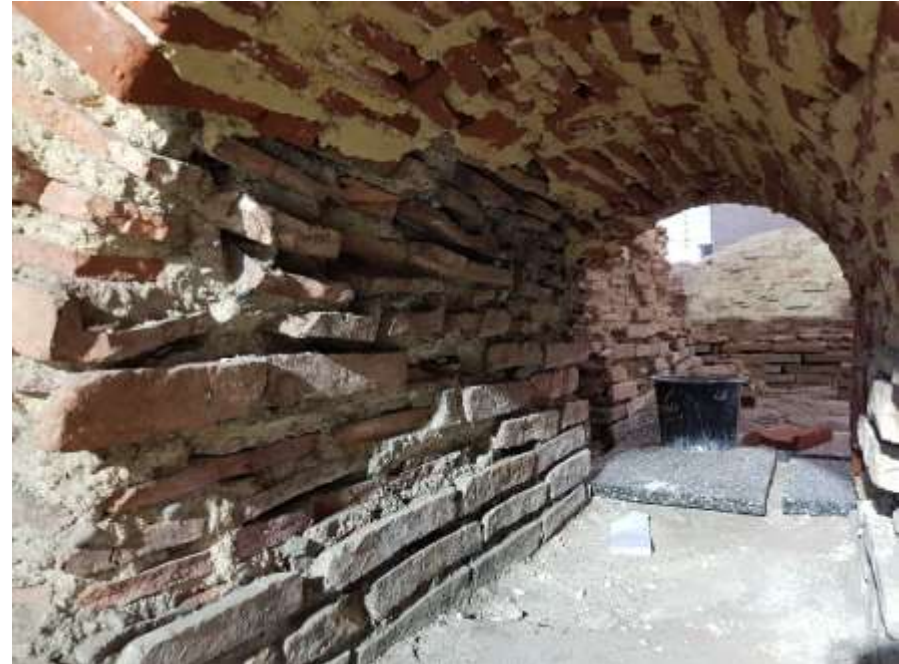
Afb. 4.3 De meest westelijke luchtdoorvoer in de funderingsmuur tussen het caldarium en het tepidarium werd bij de omvorming van de verwarmde ruimtes niet dichtgezet (foto: PANSa BV).
