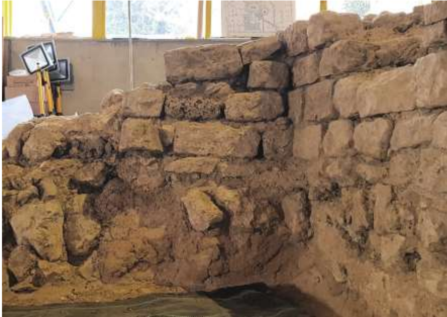
Afb. 2.74 Het zuidelijke deel van de oostmuur (links) vormt een bouwkundige eenheid met de zuidmuur (rechts) (foto: PANSA BV).
