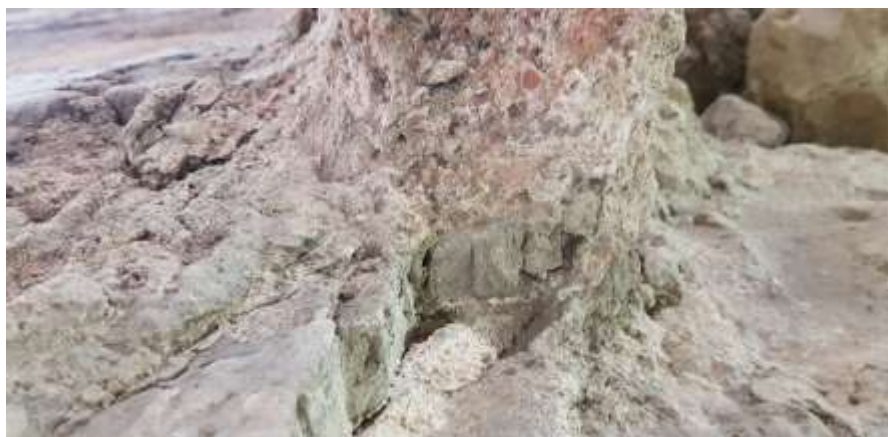
Afb. 2.19 Frigidarium , oostzijde met rand van het mozaïek waarop waterkerend pleisterwerk met een overmaat aan gebroken en gemalen keramisch materiaal aansluit (foto: PANSA BV).
