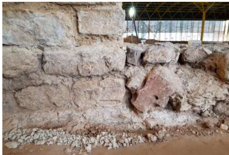
Afb. 2.48 Noordmuur van westelijke palaestra (rechts) staat koud tegen noordwesthoek apodyterium (foto: PANSa BV).
