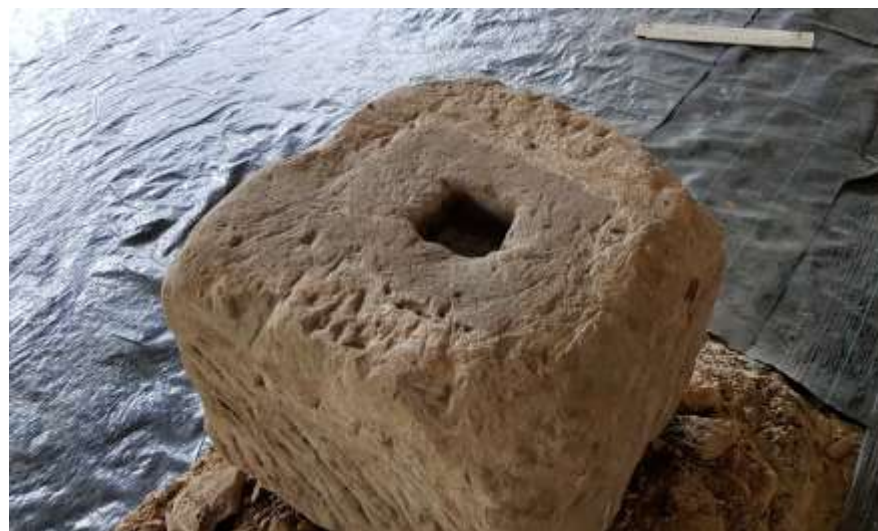
Afb. 2.70 Bovenzijde van zesde basisblok toont bijna vierkante aftekening van 33 x 29 cm en een dookgat (foto: PANSA BV).
