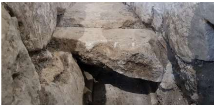
Afb. 2.56 In de bodem van het grote afvoerkanaal toont het laatste, meest westelijke blok Norroy kalksteen sporen van ruwe bewerking (foto: PANSA BV).
