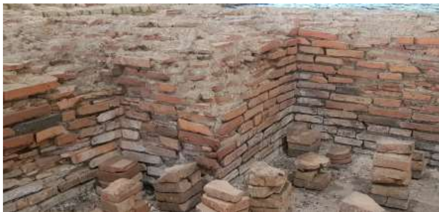
Afb. 2.26 Tepidarium , noordoostelijke hoekverzwaring (foto PANSA BV). De noordelijke funderingsmuur heeft in de basis een dikte van 75 cm. Aan de zijde van het frigidarium lopen vloerresten, inclusief de daarbij behorende stafband, 15 cm door over de funderingsmuur. Dit betekent dat het
