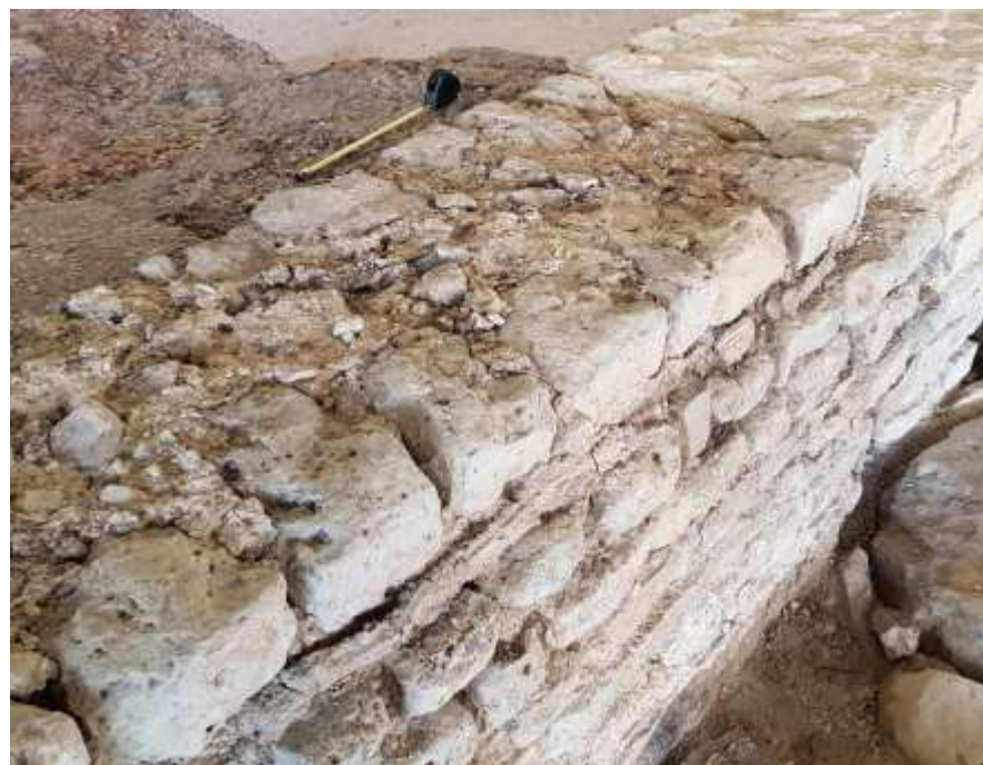
Afb. 3.5 Westmuur apodyterium ; inspringing markeert overgang tussen fundering en opgaand werk in opus vittatum simplex (foto: PANSA BV).
