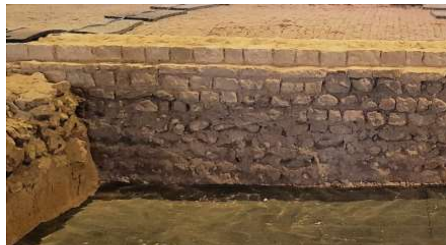
Afb. 3.3 Oostmuur apodyterium ; de onderste helft is tegen afgestoken bodemprofiel aangebracht, bovenste helft (rechts) is opgemetseld (foto: PANSa BV).
