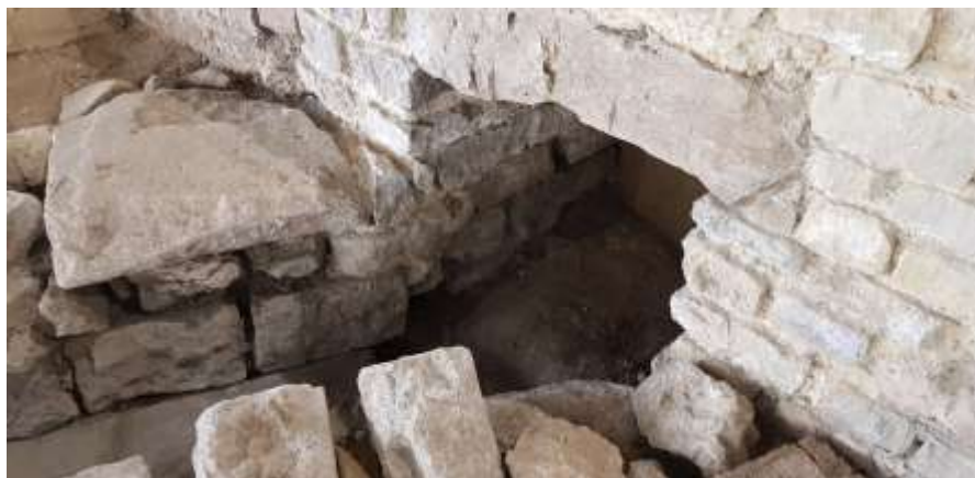
Afb. 2.55 Doorvoer van het afvoerkanaal in de westmuur van het apodyterium (foto: PANSA BV).
