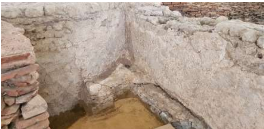
Afb. 2.22 Aansluiting sudatorium (links) en tepidarium (rechts); op de eerste 82 cm uit de westmuur van het tepidarium is op de ringmuur van het sudatorium pleisterwerk aangebracht.
