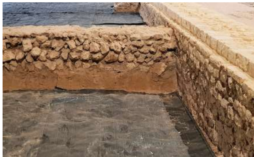
Afb. 2.73 De zuidmuur van de groep van drie vertrekken staat koud tegen de oostmuur van het apodyterium (foto: PANSa BV).
