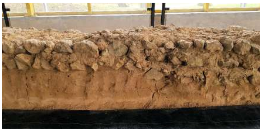
Afb. 2.46 In verband met het in noordwestelijke richting aflopende terrein werd de zuidelijke funderingsmuur van de westelijke palaestra in westelijke richting getrapt dieper aangelegd (foto: PANSA BV).
