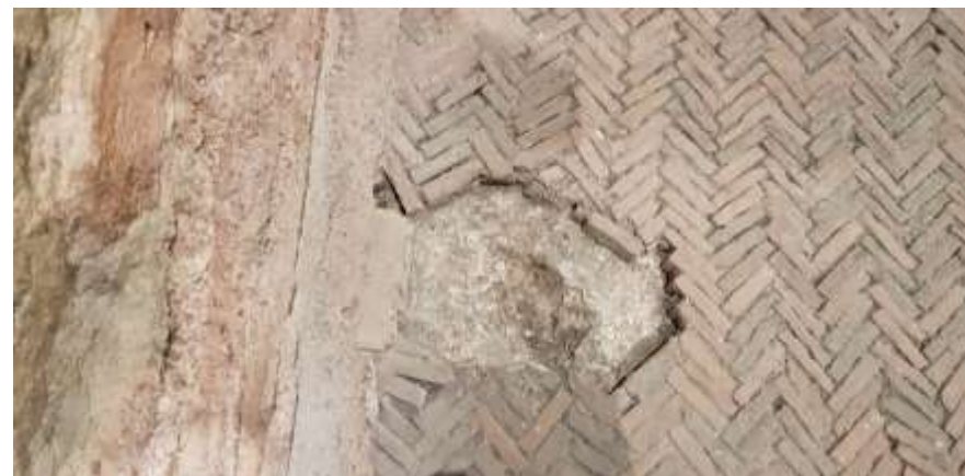
Afb. 2.18 Verstoring in de vloer van de westelijke piscina (foto: PANSa BV).
