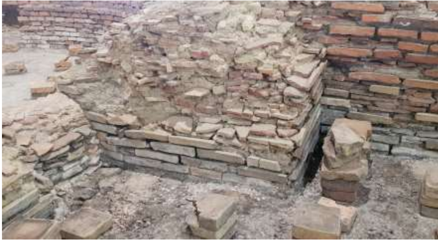
Afb. 2.27 Tepidarium , noordwestelijke hoekverzwaring en dichtgezette lichtdoorvoer naar sudatorium (links) (foto: PANSA BV).
