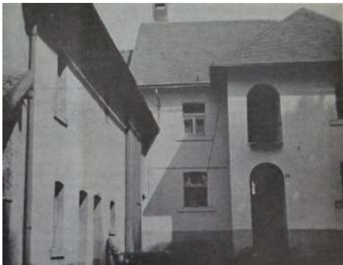
Het pand vóór de verbouwing.
