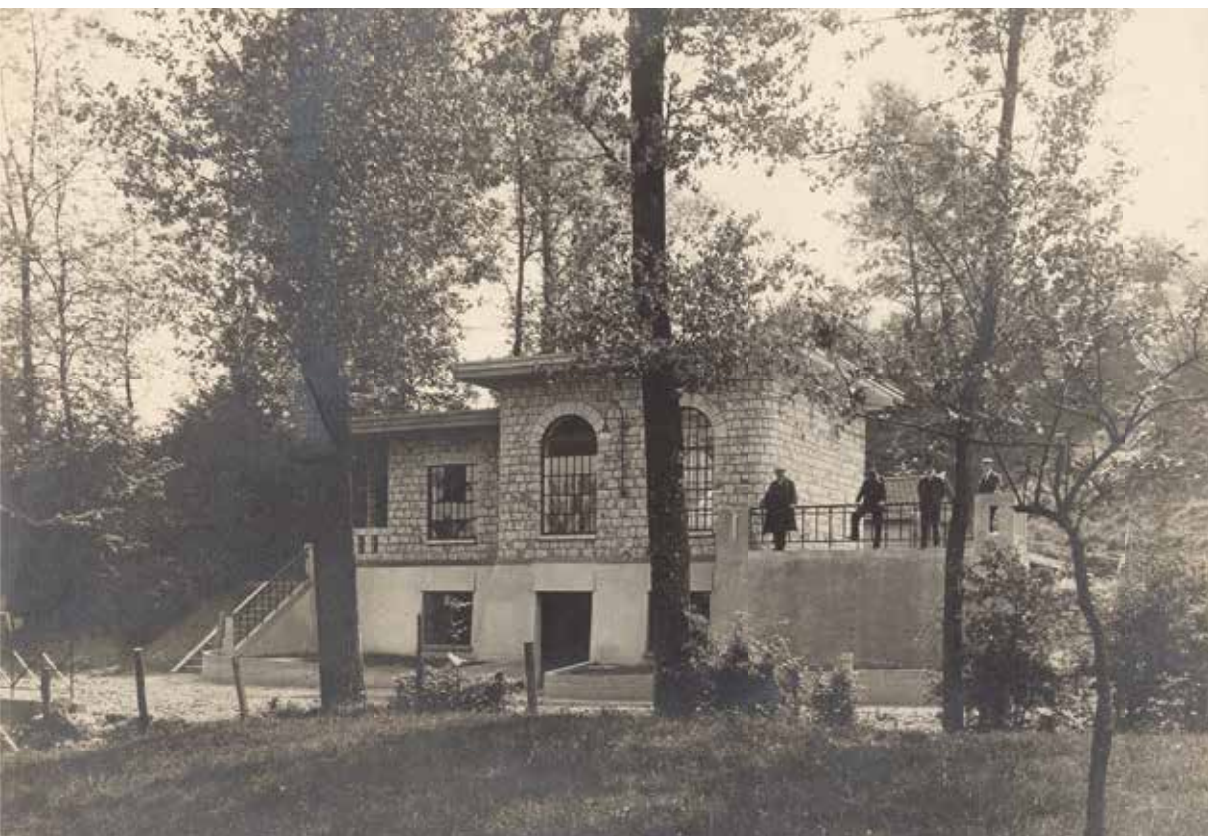
Pompstation Craubeek van de gemeente Heerlen. Tweede van links: A.A.M. Pel, directeur Gemeentebedrijven Heerlen, 1922. Beeldcollectie HCL, Heerlen
