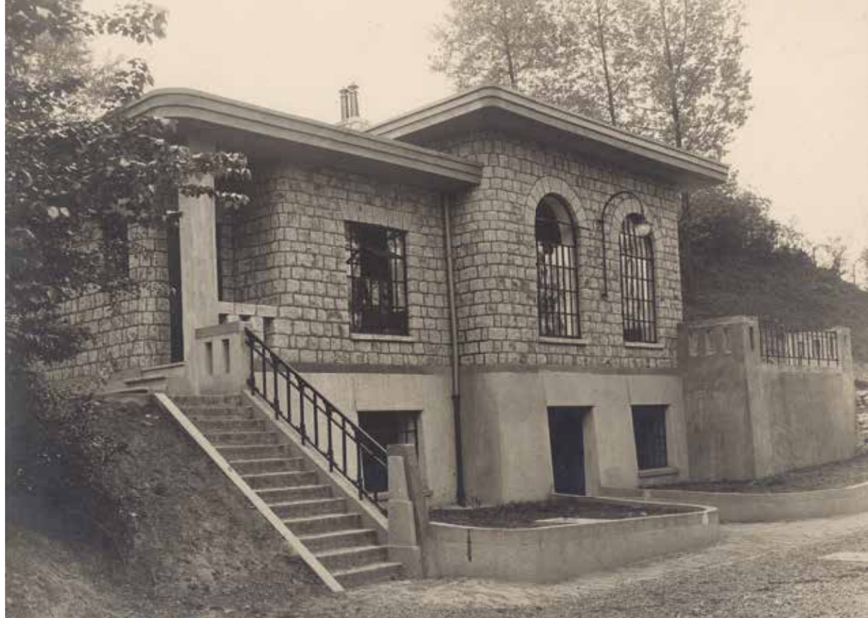
Pompstation Craubeek van de gemeentewaterleiding Heerlen aan de Zevensprong in Voerendaal, 1922. Beeldcollectie HCL, Heerlen
