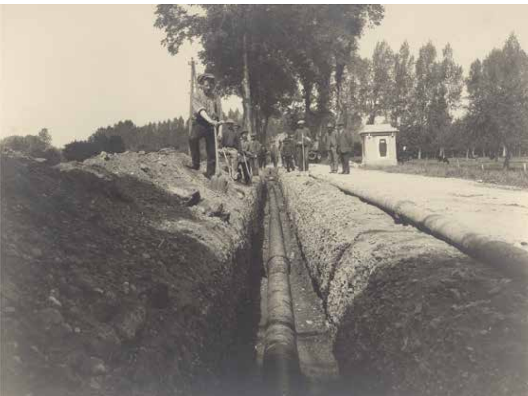
Pagina hiernaast: Aanleg watertransportleiding van het pompstation Craubeek van de gemeente Heerlen. Geheel rechts staat A.A.M. Pel, directeur Gemeentebedrijven Heerlen, 1919. Beeldcollectie HCL, Heerlen
